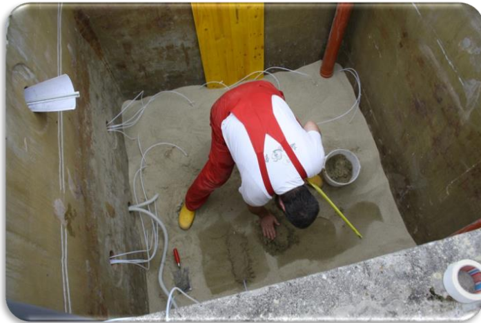
Abb. 59 Einbau der TCE-Injektionsleitungen
