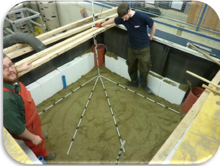
Abb. 51 Einbau der Bodenluftabsaugung
