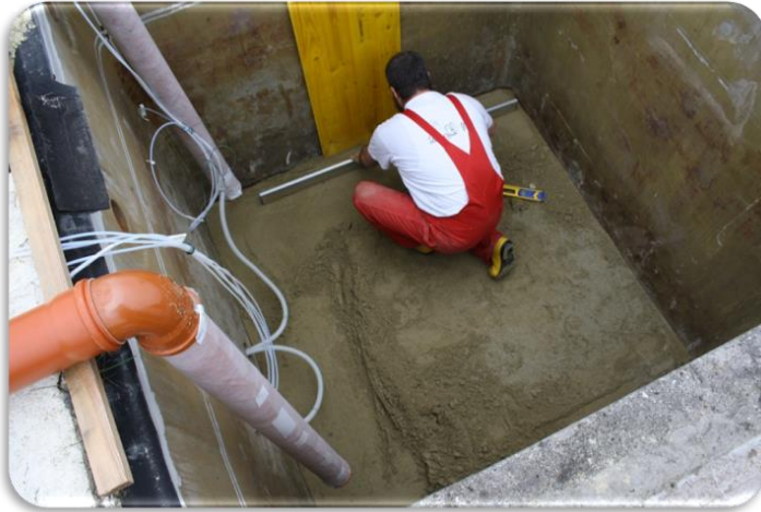
Abb. 58 Herstellen einer ebenen Oberkante des GW-Stauers
